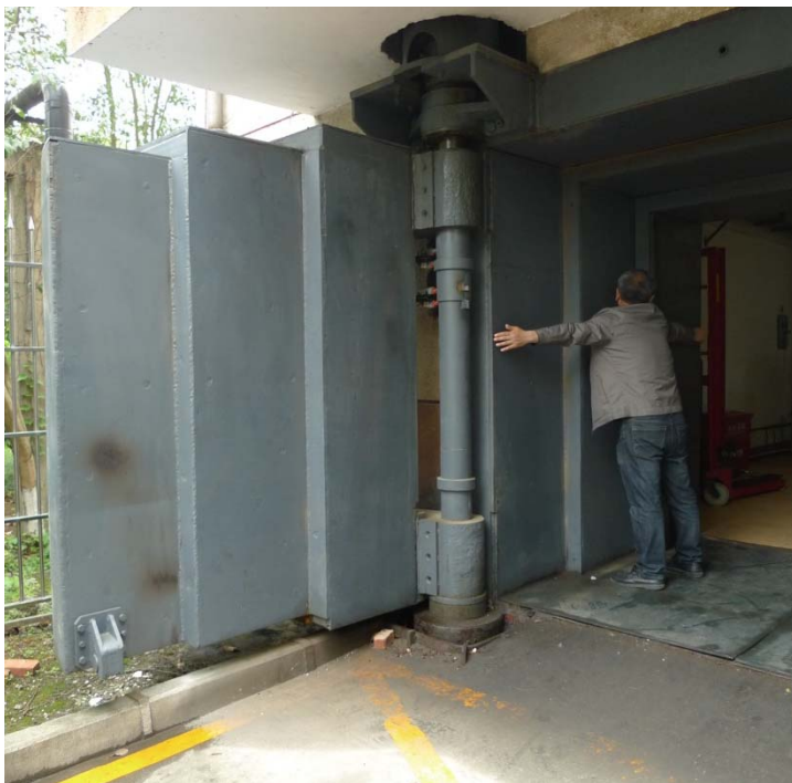
图10-4 工件设备进出屏蔽门
